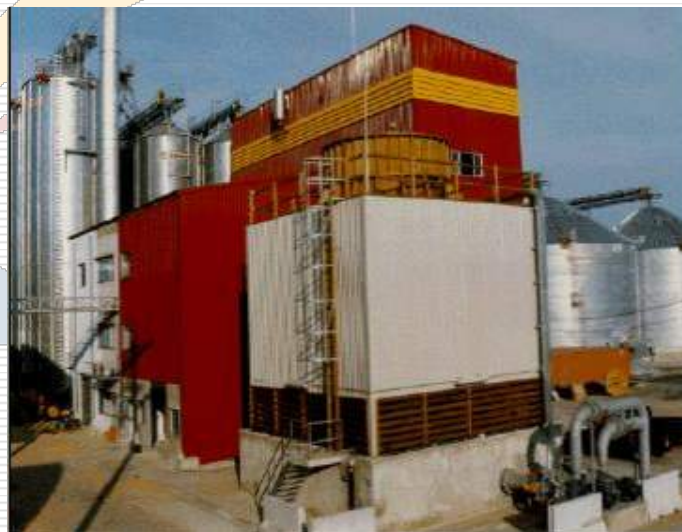
泰國一座2.5MW蒸汽渦輪稻殼發電廠，1997年運轉，每小時處理17噸。 圖片取自：COGEN3 website, EC-ASEAN COGEN Program, http://www.cogen3.net/
