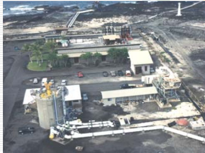
海洋溫差發電廠—210 kW美國夏威夷州
